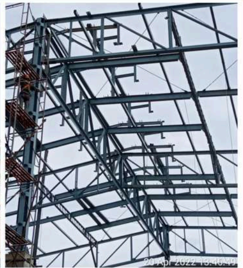
Pembangunan Kontruksi baja expansion pabrik ukuran.22 X 70 Meter - PT. Nusahadi Citraharmonis
