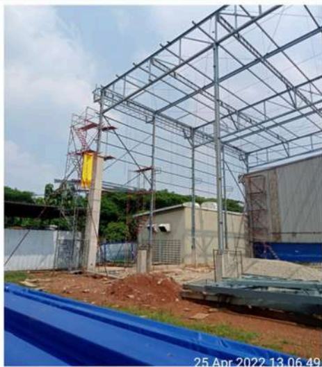
Pembangunan Kontruksi baja expansion pabrik ukuran.22 X 70 Meter - PT. Nusahadi Citraharmonis
