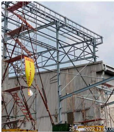
Pembangunan Kontruksi baja expansion pabrik ukuran.22 X 70 Meter - PT. Nusahadi Citraharmonis
