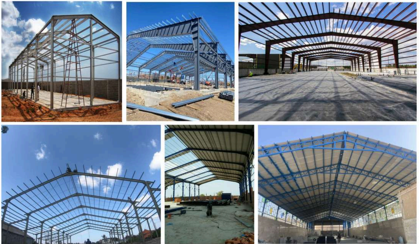
Pembangunan Kontruksi baja Warehouse/ Workshop
